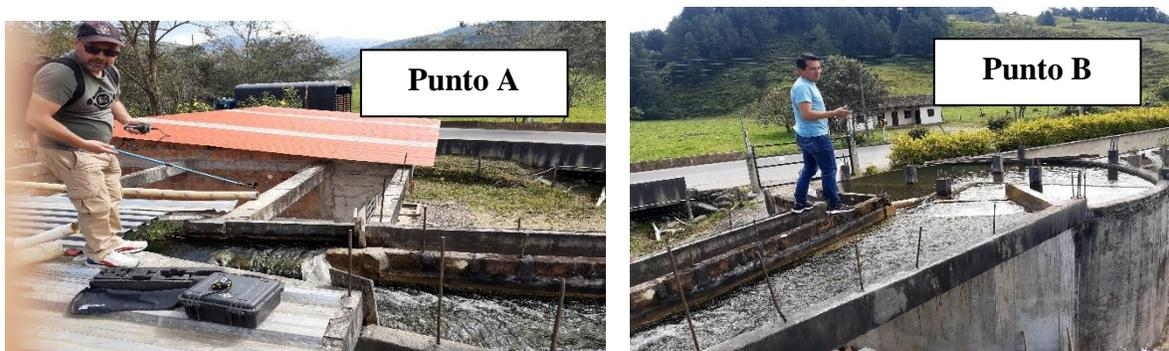
**Figura N°4.** Se procede a realizar las mediciones del caudal, pero antes se escogen los puntos de referencia para medir en distintas profundidades, el caudal del puesto de trabajo N°1.
