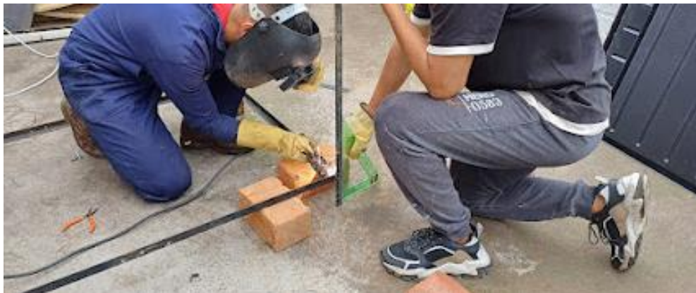
Figura 34 Proceso de construcción anaquel
