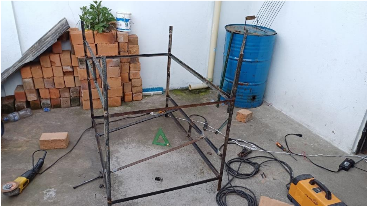
Figura 35 Anaqueles en construcción
