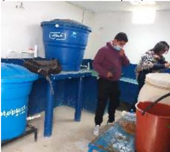
Infraestructura del acueducto Alto San Pedro y Barbero
