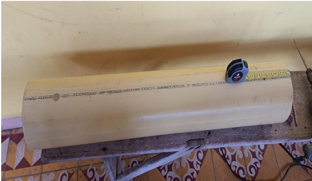
Construcción de pre filtro horizontal
