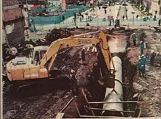
Avanzan los trabajos de la red de acueducto y alcantarillado en la carrera 27 entre calles 16 y 15, centro de la ciudad, con la ejecución directa de la Empresa de Obras Sanitarias de Pasto, Empopasto y una inversión de $8.250 millones. El proyecto se desarrolla en las etapas 2 y 3, entre las calles 16 y 10. Foto: DIARIO DEL SUR
