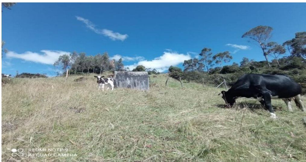
Tanque de almacenamiento de agua sector Mocondino alto
