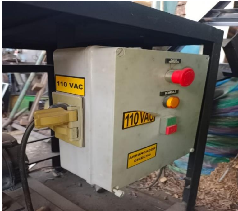
Instalación de la caja de control
