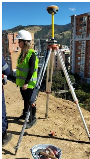
Instalación de GNSS
