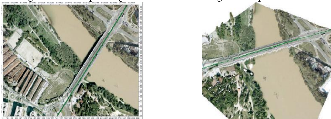
Análisis de infraestructura mediante LiDAR. Fuente: Magdaleno y Martínez (2006)
