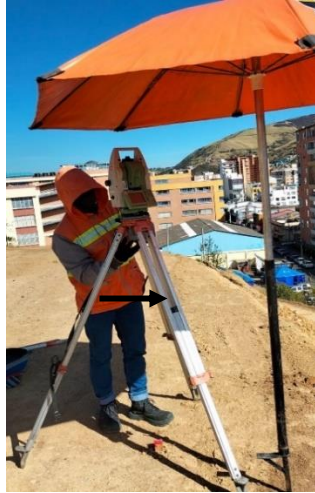
Montaje de estación
